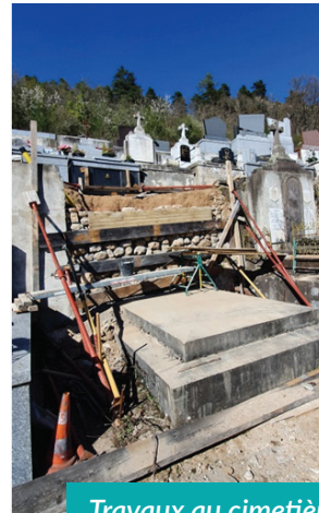
Travaux au cimetière
