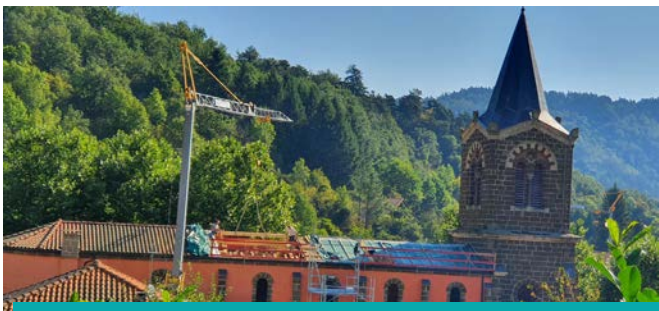
Réfection d'une partie de la charpente de l'église St Symphorien et reprise de façade pour 50 000 €, en 2021. Cofinancé par 4 050€ de dons, 4 000 € par le Département, 12 400 € par l'Etat, 5 700 € par la Fondation du patrimoine et la Région, et la Commune.
